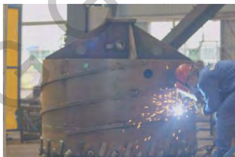
▲ 焊接现场 Welding site
